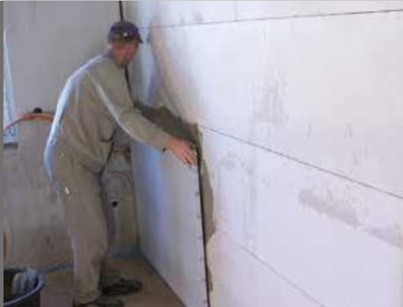
Climate Board-materiaalin asettaminen
